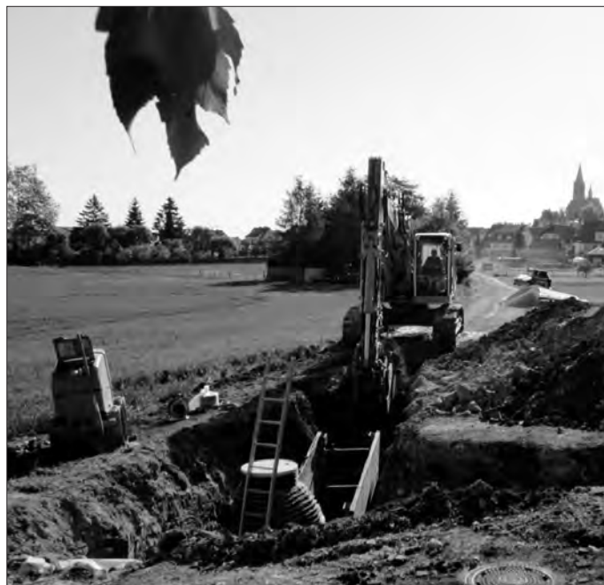
Kurz vor Bauabschluss des Verbindungssammlers zwischen Großbartloff und Effelder.
