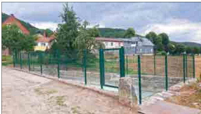
Sanierter Feuerlöschteich im „Zwingel“
