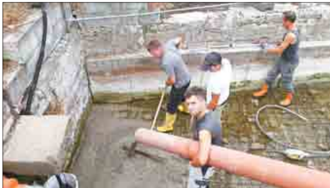
Betonieren der neuen Bodenplatte
